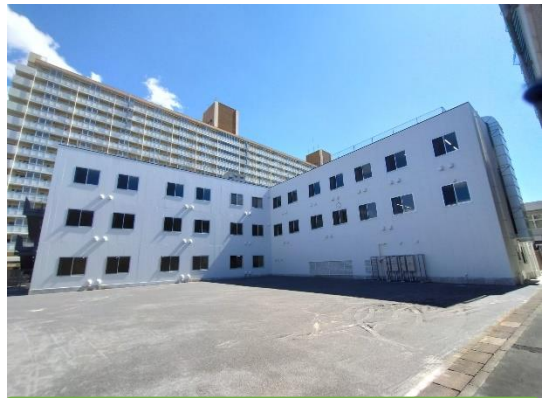
グラウンドに仮設校舎が完成。4月から使用開始
