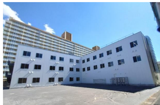
グラウンドに仮設校舎が完成。4月から使用開始
